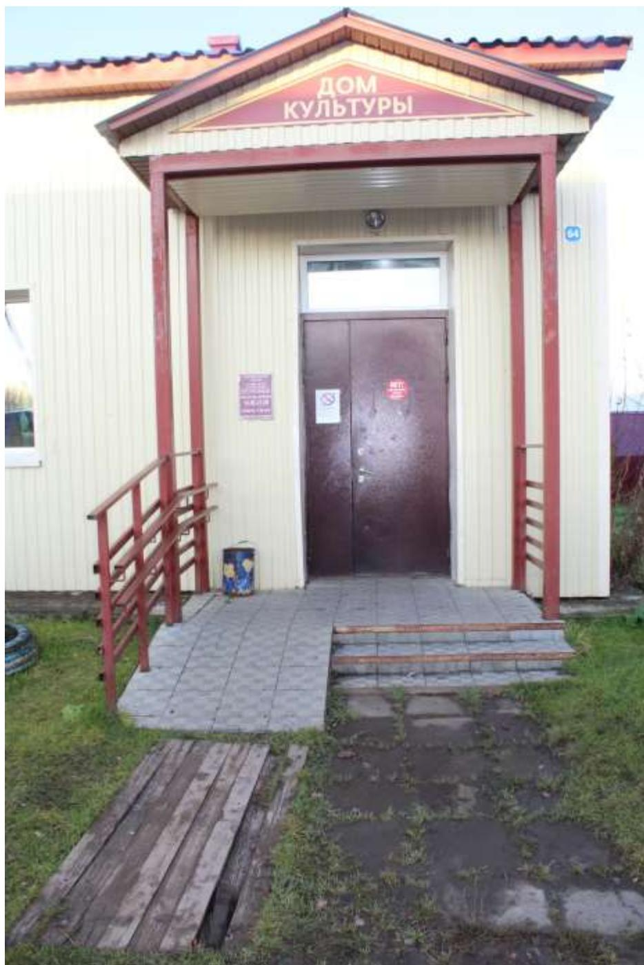
В доме культуры ширина входной двери 1,5 м., имеется порог высотой 5,0 см.; Входная площадка перед дверью размерами 2,5м.\*1,0м. Отсутствует тактильная предупреждающая полоса перед дверью; отсутствует антискользящее покрытие.
